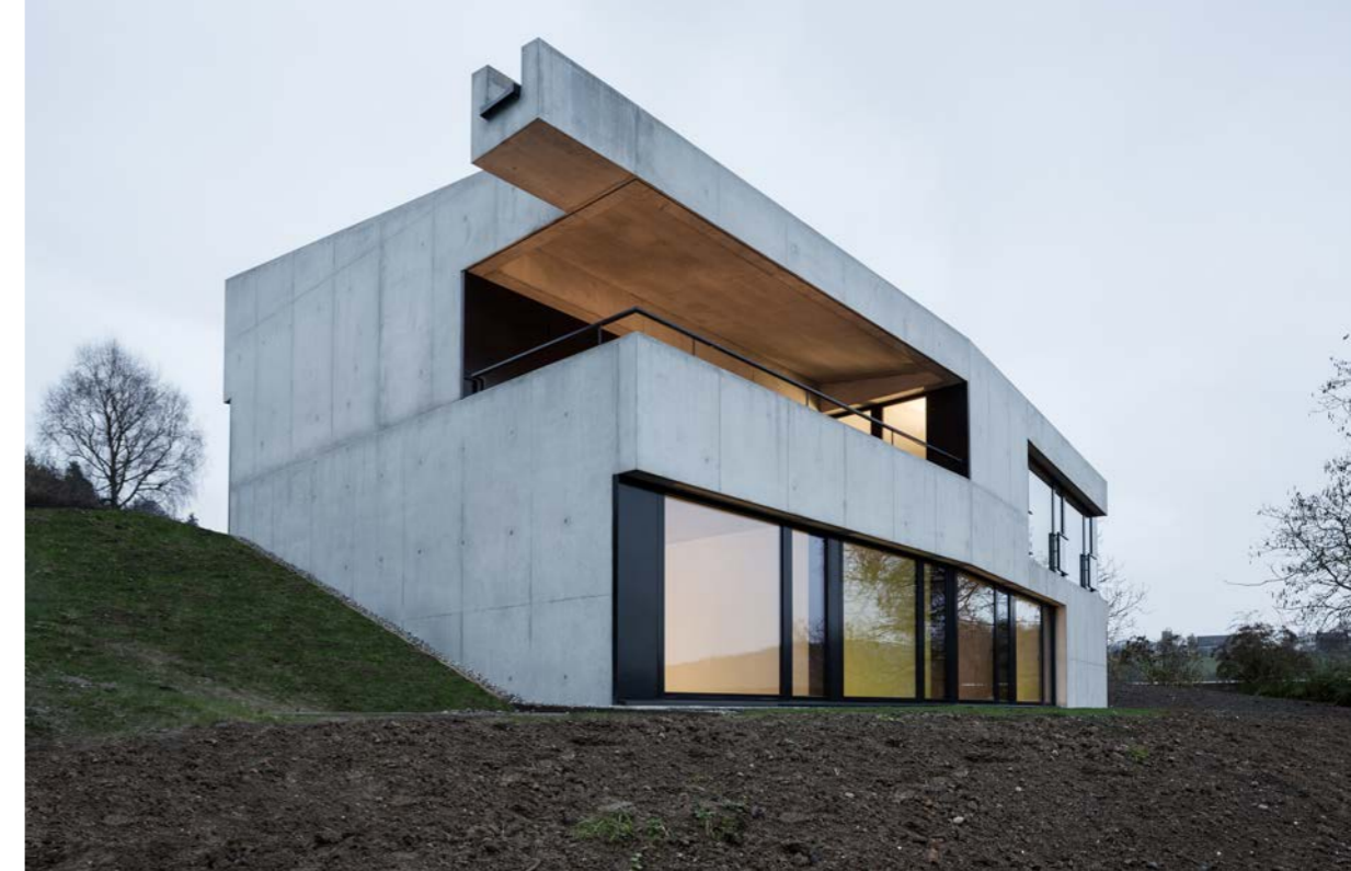
Jäger Zöh Architekten / Einfamilienhaus in Eglisau ZH 1. Rang bei privatem Studienauftrag / Fertigstellung 2014
